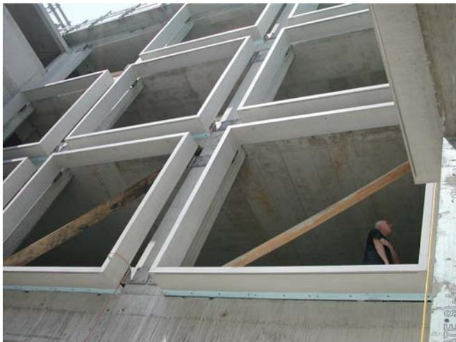
Dabei werden als Fassadengestaltung verglaste Betonrahmen mit einer Abmessung von 300x300 cm eingesetzt (Bild 1). Die Elemente sollten auf Wunsch des Architekten eine möglichst schlanke Struktur aufweisen. Daher ergab sich im Querschnitt eine konisch von Innen 12 cm auf Außen 8 cm verlaufende Form, mit einer Tiefe von 34 cm. Aufgrund dieser schlanken Form ergibt sich ein sehr hoher Armierungsgehalt.
