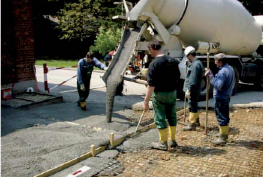
Bild 7: Nachverwendung der Betonmischen für Parkplatzflächen
