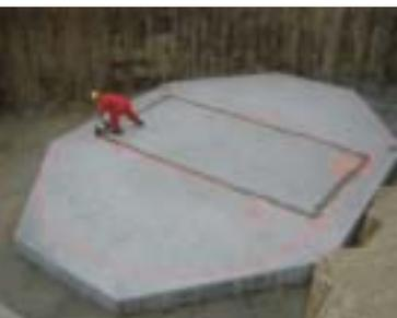
Ortbetonfundament als Grundlage für Sammelbecken in Segmentbauweise
