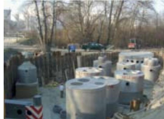
Darstellung Abscheideranlage gesamt, bestehend aus Sammelbecken, 3 Mineralölabscheideranlagen, 3 Aktivkohleschächten sowie aus dem Pumpwerk (Hebeanlage)
