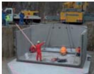
Versetzarbeiten von U-Element und Rundelement (Sammelbecken) auf Ortbetonfundamentplatte
