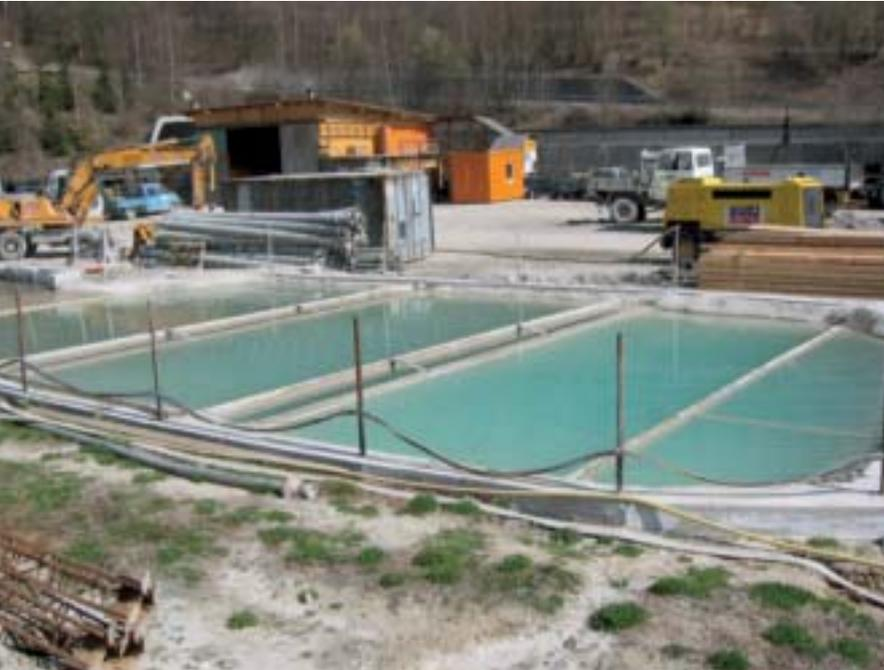
Gewässerschutzanlage für den Tunnelbaubetrieb
