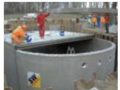
Aufsetzen der Flachabdeckungen auf die Einzelsegmente des Sammelbauwerks
