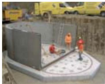
Auftragen von Ankermörtel als Ausgleichsschicht zwischen Fundamentplatte und Sammelbecken für 2. Rundelement
