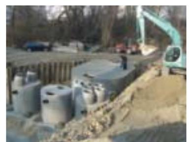
Teilweises Hinterfüllen des Sammelbeckens sowie der Mineralölabscheideranlagen
