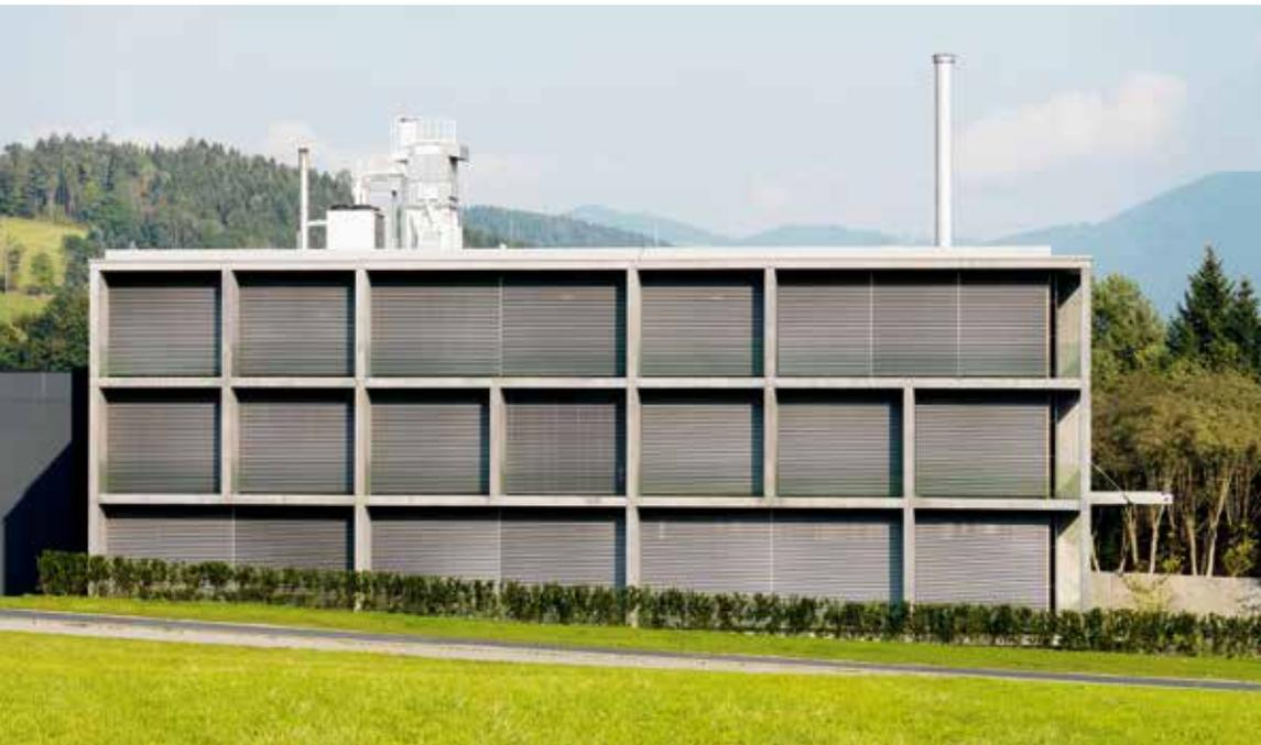
hergestellt. Die Gebäudehülle wurde umfassend gedämmt (Kern-dämmung). Für die transparenten Bauteile wurden Fenster mit Dreifachverglasung und einem UW-Wert unter  $0,9 \text{ W/m}^2\text{K}$  verwendet. Der hohe Energiedurchlassgrad sorgt für die optimale Nutzung der solaren Einstrahlung.
