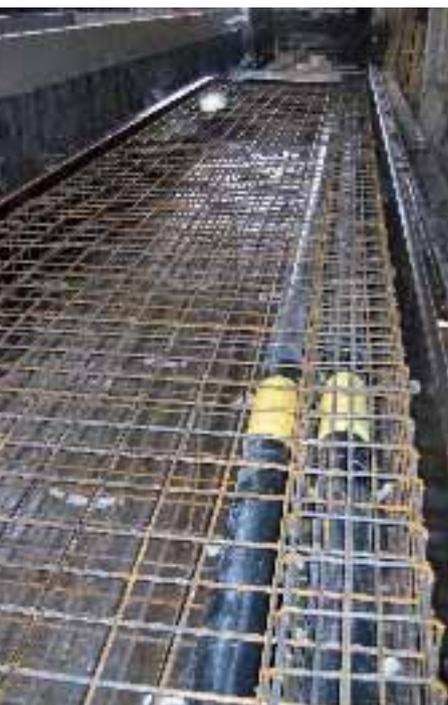
Abb. 1: Fertig gebundene Bewehrung des Brückentragwerkes, 2 St. DN 150 Kabelziehrohre und Schrammbord-Aufschalung
