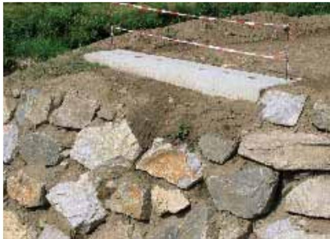
Abb. 2: Linkes Widerlager und Hüllrohre (6 St.) für Verdornung von Brückentragwerk
