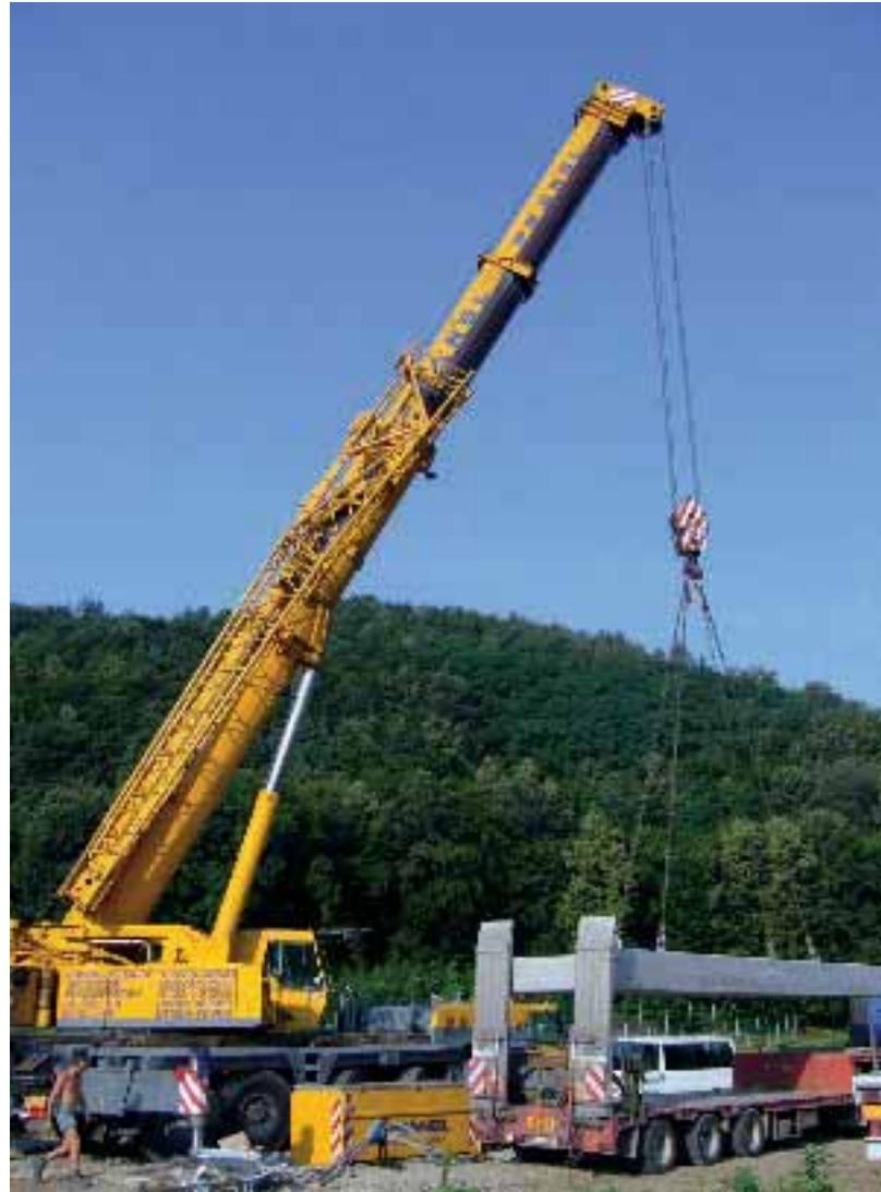
Abb. 4: 160-t-Kran beim Anheben des Brückenfertigteiltragwerkes vom Tieflader
