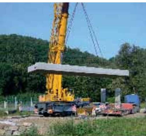
Abb. 6: Fertiges Brückentragwerk ohne Geländer
