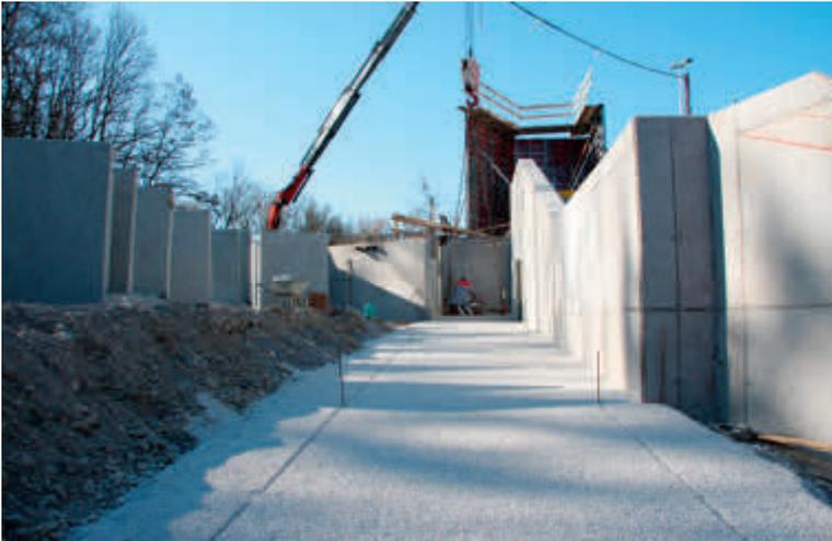
Abb. 2: Feinplanum vor dem Versetzen der Fertigteile
