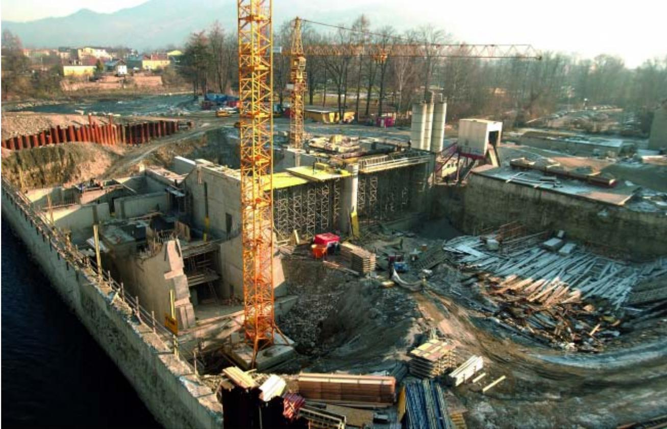
Bild 13: Turbineneinlauf, Einrüstung der Wehrbrücken
