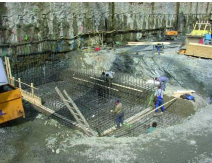
Bild 6: fertig gestellte Sohlplatten
