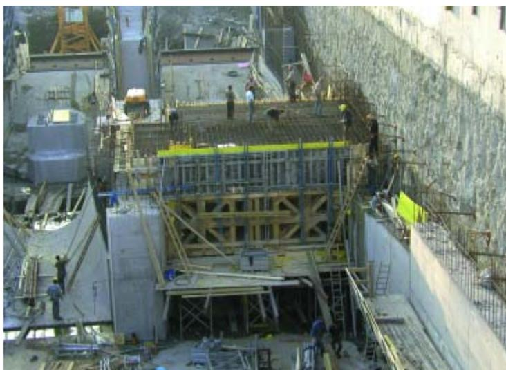
Bild 12: Schalung und Bewehrung Saugrohrdecke
