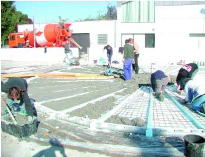
Bild 7: Betonieren der Stahlbetonplatte mit 10 m Durchmesser
