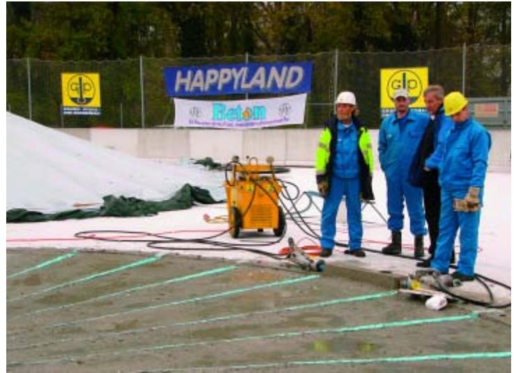
Bild 8: Erhärtete Stahlbetonplatte mit angesetzten Spannpressen für den Formprozess
