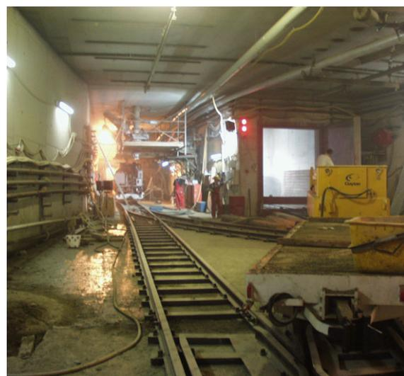
Bild 2: Personen- und Materialdruckschleusenkammer
