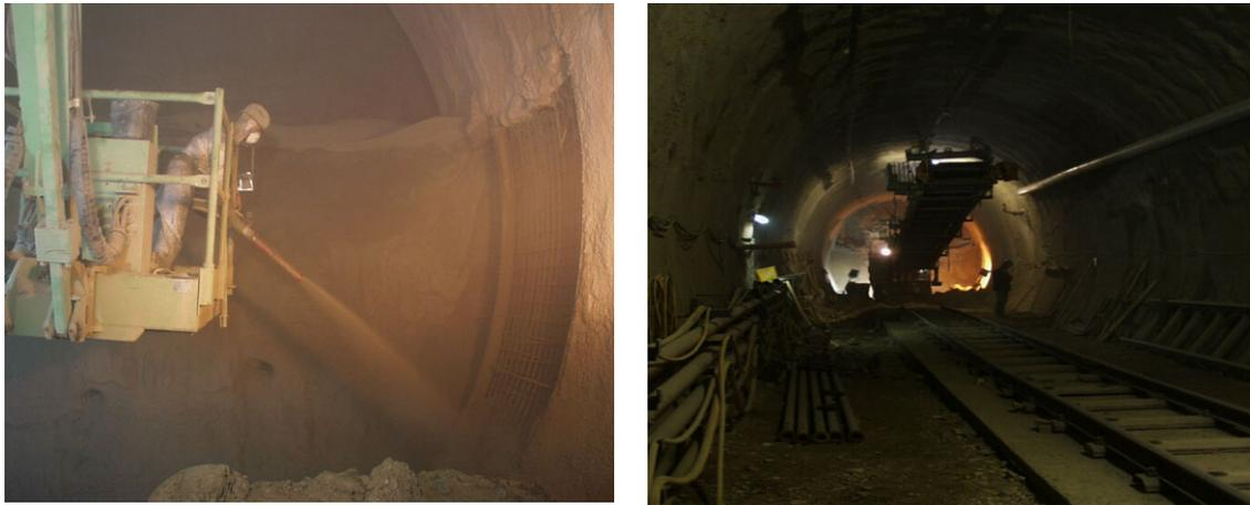
Bild 3: Sicherungsmaßnahmen mit dem Trockenspritzbetonverfahren an der Ortsbrust
