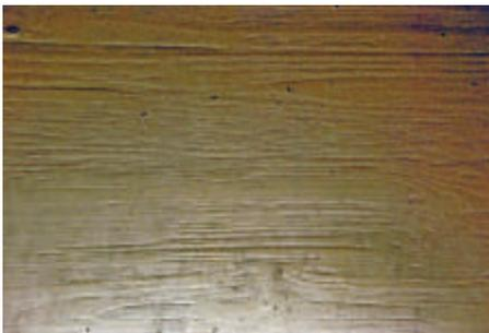
Kurz vor dem Einzug wurden die Sichtbetonbauteile oberflächlich kurz angeschliffen – dadurch kommt die Holzmaserung der Dreischichtplatten stärker zur Geltung.
