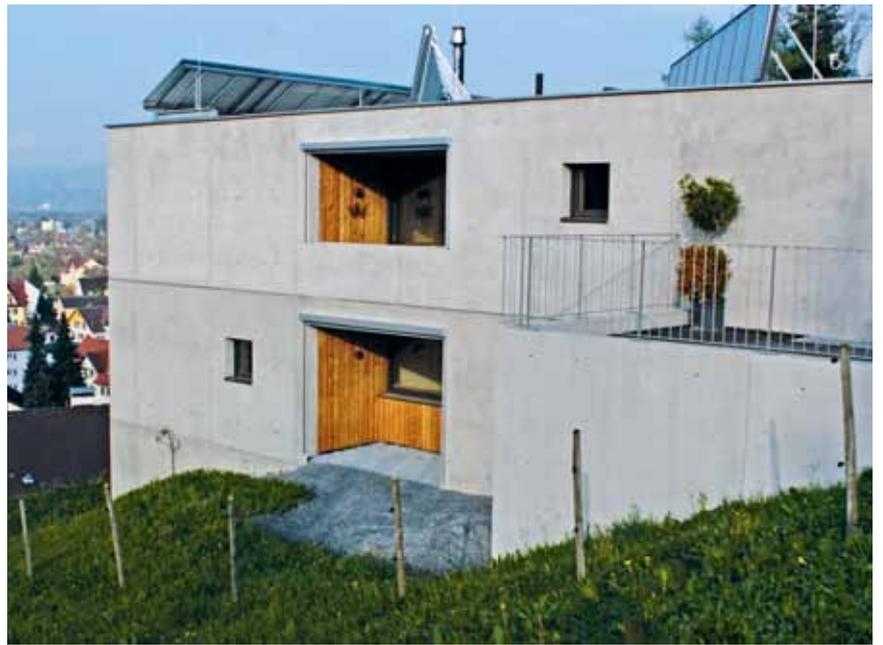
Über 47 m<sup>2</sup> thermische Sonnenkollektoren wird der jährliche Wärmebedarf mit 80 % gedeckt. Der Rest wird über einen Holz-Speicherofen beheizt. Zusätzlich betreiben die Bauherren eine 4,6-kW-Fotovoltaikanlage auf dem Flachdach. Als Energiespeicher dienen 60 m<sup>3</sup> Stahlbetondecken – Bauteilaktivierung, eine Wandheizung im Wohn- und Essbereich sowie eine Ziegeltonplatte im Fußbodenaufbau. Als Energieerzeugung sind auf dem Flachdach 47 m<sup>2</sup> thermische Solar-
