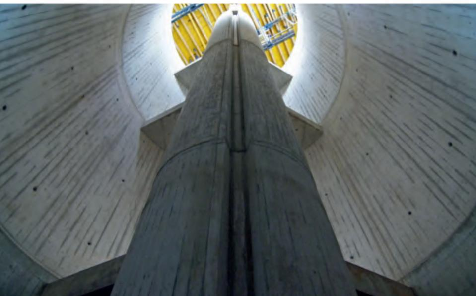
Der gesamte Baukörper ist in monolithischer Bauweise aus hellem Sichtbeton hergestellt.
