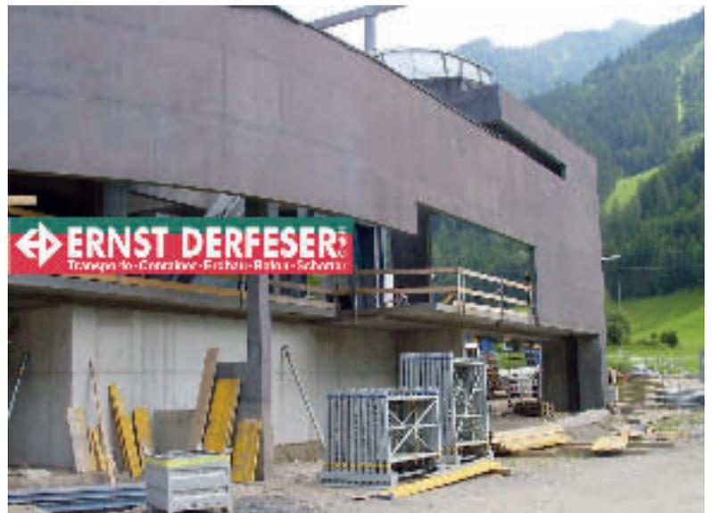
Bild 2: Anthrazitfarbener Sichtbeton der Talstation Ahornbahn im Zillertal Foto: © Fa. Derfeser
