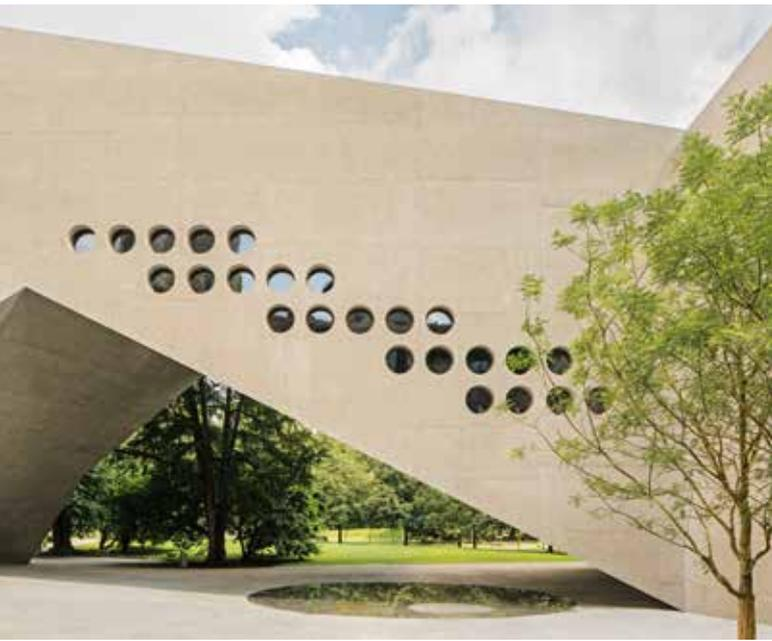
Den Tuffstein-Fassaden des Altbaus entspricht der eigens für dieses Projekt entwickelte Tuff-Beton der Neubaufassaden.
