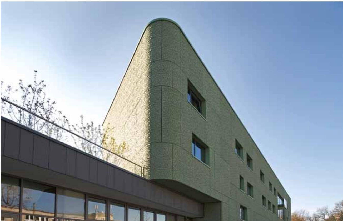
Farbsättigung und Leuchtkraft der grün durchgefärbten Fertigbetontafeln werden durch die Verwendung von Weißzement und einen hohen Anteil an kobaltblauen Pigmenten erhöht; die als Zuschlagstoff beigemischten Quarzitkörner glänzen im direkten Licht.
