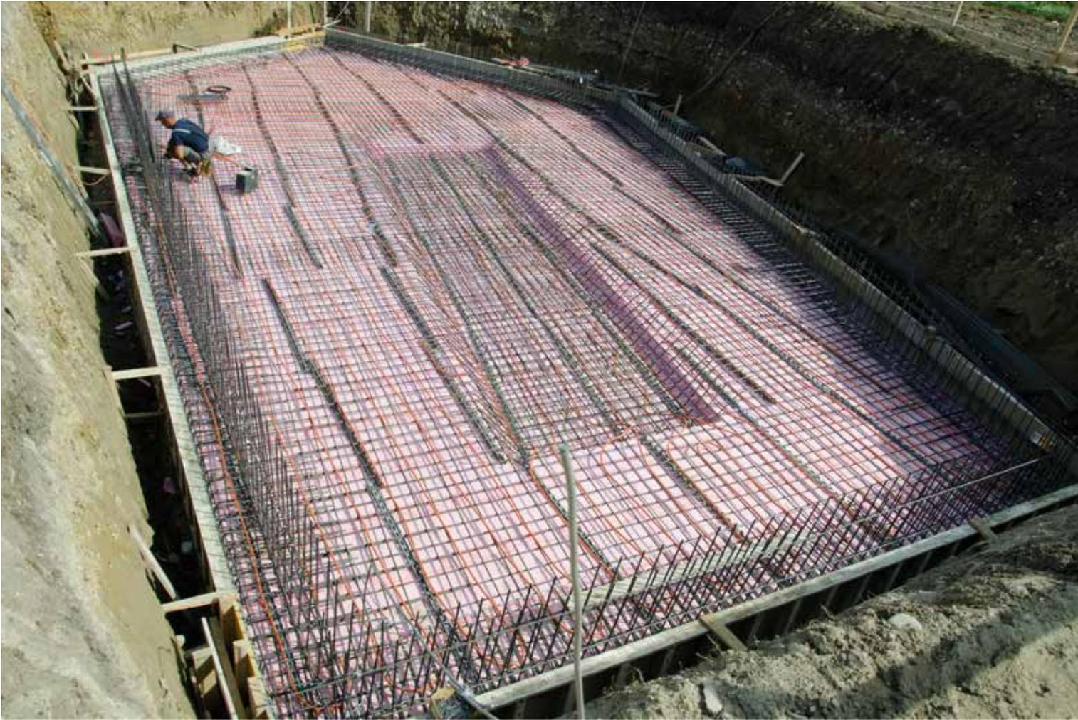
Die Bodenplatte wird durch ihre Aktivierung im wahrsten Sinne des Wortes „zum Fundament der Wärmeversorgung“.
