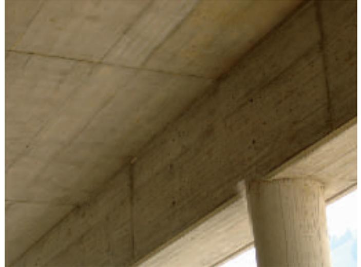
Bild 3: Saubere Betonoberflächen bei extrem hohen Fasergehalt
