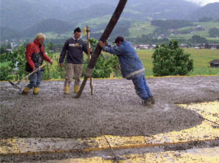
Bild 2: Das Verlegen von Betonstahl wird eingespart
