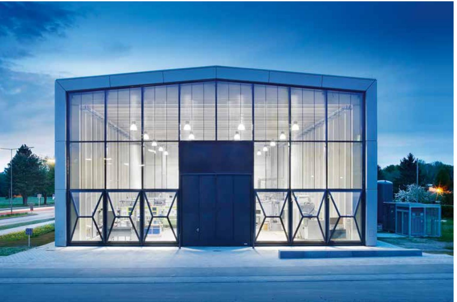
Konstruktion ausgebildet. Mit dem Ziel der Optimierung des Wärmeschutzes der Fassade wurden in die Scheibenzwischenräume der opaken Öffnungselemente vliesbelegte, hochdämmende Vakuumisolierpaneele eingelegt.
