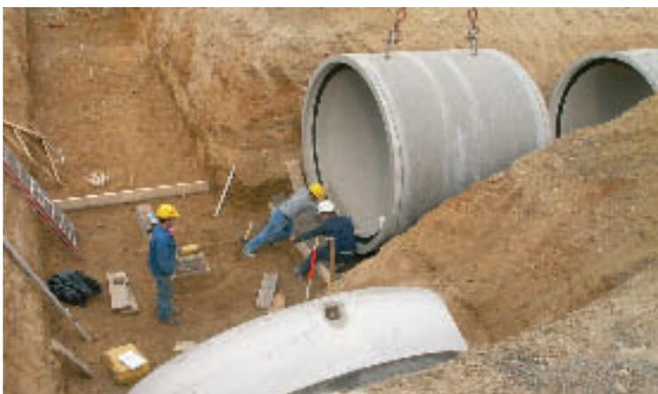
Abb. 10: Versetzen TT-Elemente im Terminal
