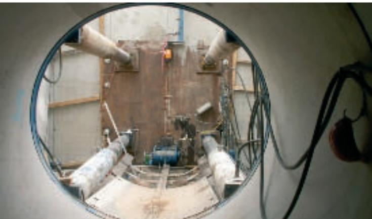
Abb. 6: Pressvortrieb unter Bestand
