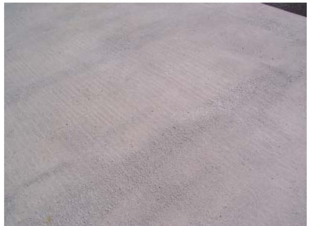
Bild 9: Frei bewitterte abgezogene Fläche mit hohem Fasergehalt (Ritzer Beton/Kössen)
