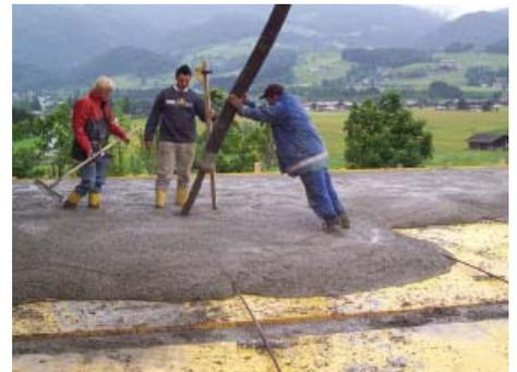
*Bild 6: Betonage einer Stahlfaserbetondecke nach dem System TAB-Slab™ bei Ritzer Beton in Kössen (Nähe Walchsee)*
