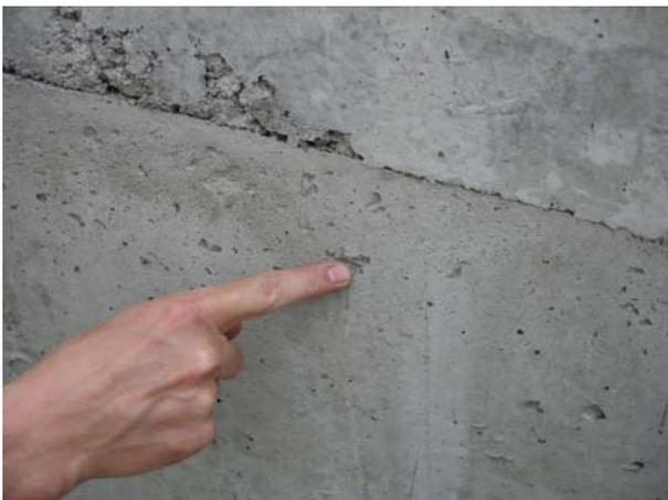
Bild 8: Die mühsame Suche nach Stahlfasern in SFRC-Bauteilen. Ca. 5 Jahre alte Außenwand in einer Betonanlage
