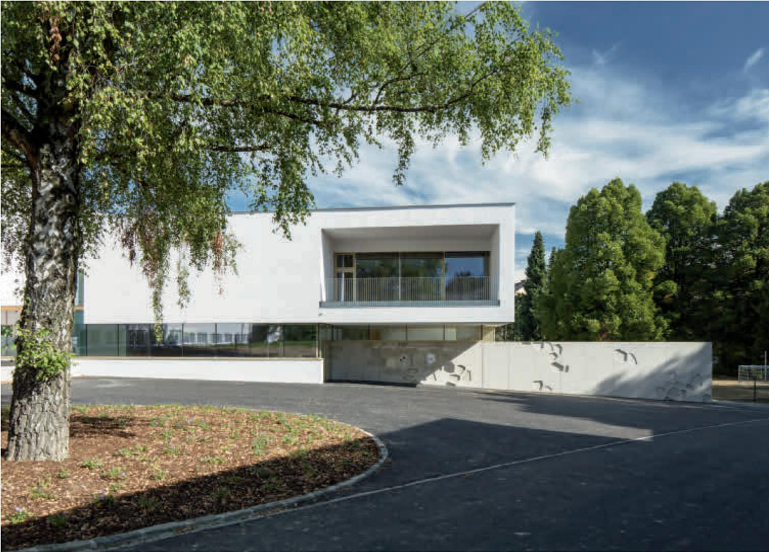
Die in die Betonscheibe eingelassenen Polygone setzen sich im Innenraum fort. Die verschiedenen tiefen Eindrücke in den Beton nehmen in plastischer Art die Farbwechsel der Innenraumpolygone auf.
