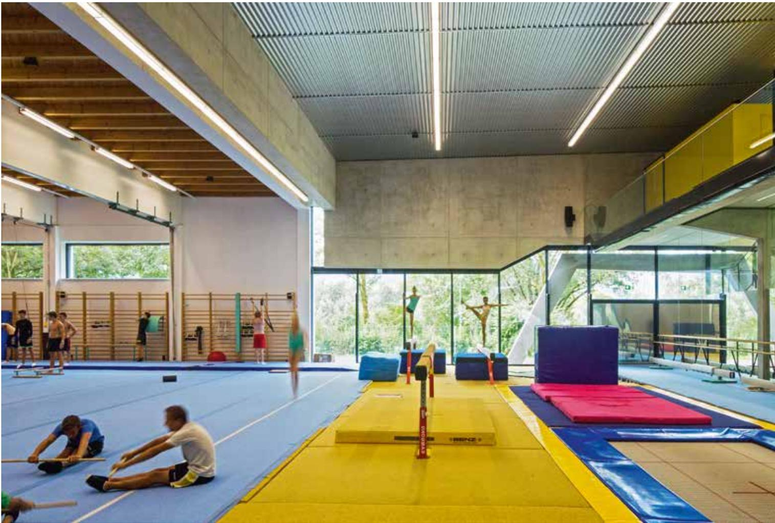
Fünf Rahmen aus hochfestem Beton tragen das obere Geschöß. Die Rahmen sind mittels Schattenfugen von der aufliegenden Decke freigespielt. Die Außenwände, welche mittels Systemschalung hergestellt wurden, sind nur punktuell mit den beiden außerhalb der thermischen Hülle liegenden Rahmen verbunden. Die Tribüne entwickelt sich plastisch aus der Deckenkonstruktion. Durch das Sichtbarmachen des Trainings kann der Sport eine neue Öffentlichkeit erreichen.
