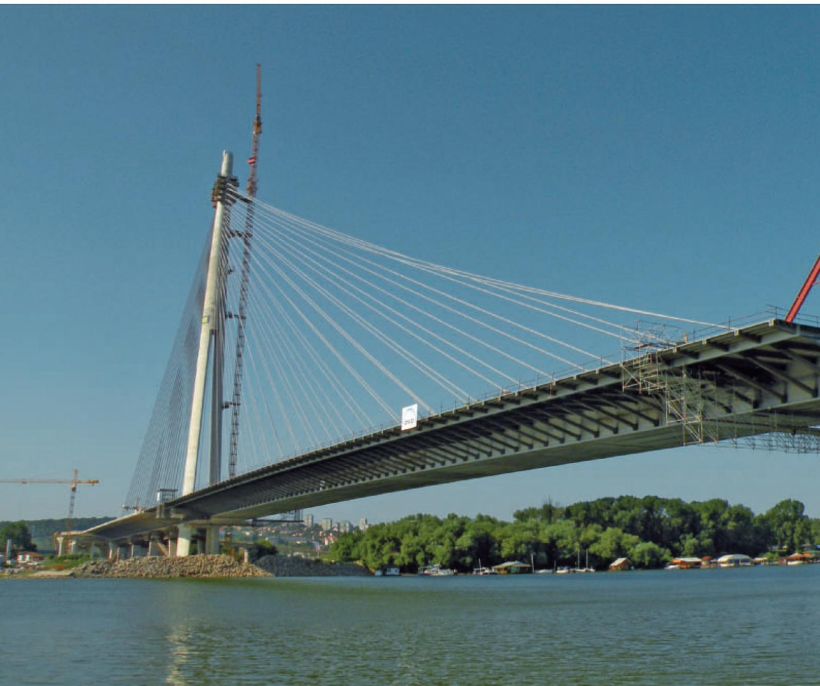
Da die Save-Brücke gemäß Vertrag ohne Beeinträchtigung der Wasserstraße und damit ohne Hilfspfeiler hergestellt werden musste, ergab sich daraus der Bauablauf. Erst nach Fertigstellung des Pylons bis zur ersten Schrägseilverankerung und gleichzeitigem Verbinden des Backspans mit dem Pylontisch konnte der Freivorbau des Hauptfeldes beginnen.
