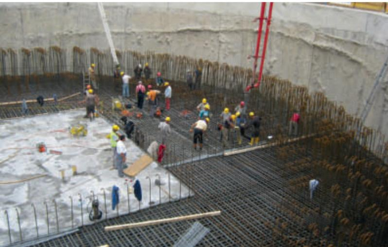
Betonage Pfahlkopfplatte Pylon, 2.700 m<sup>3</sup> erster Abschnitt
