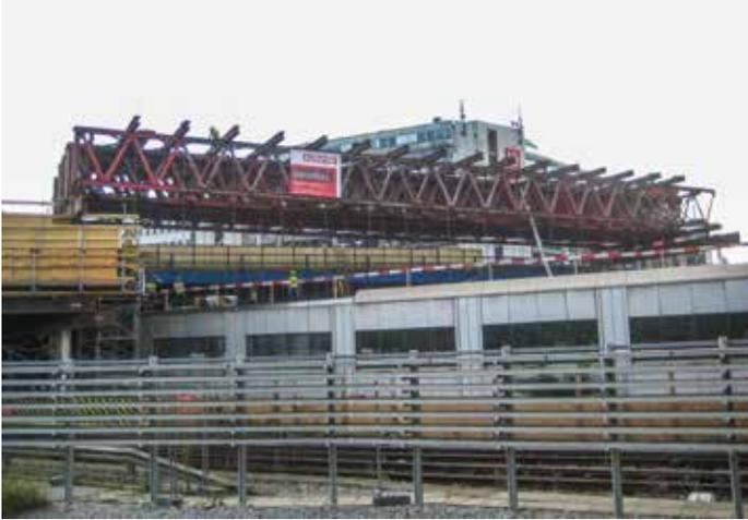
Fachwerkgerüst mit abgehängter Schalung
