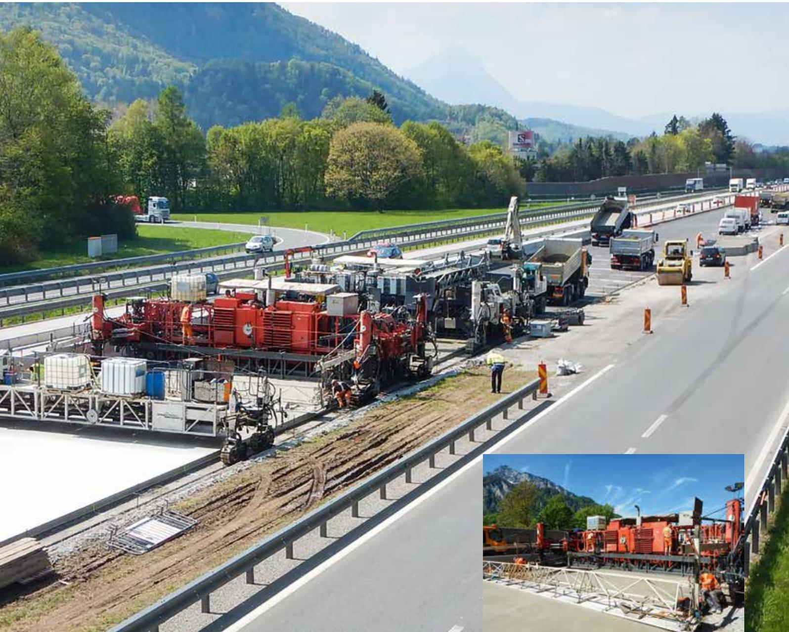
Der Oberbetonfertiger, an den im Nachgang zum sogenannten Längsglätter eine Nachlaufbohle befestigt wurde
