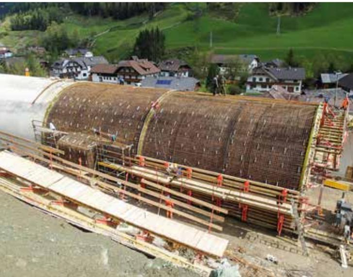
Gekoppelter Schalwagen je 12,5 m bei Bewehrungsarbeiten mit Dehnfuge im Mittelbereich – Betonierabschnitt somit 25 m je Takt
