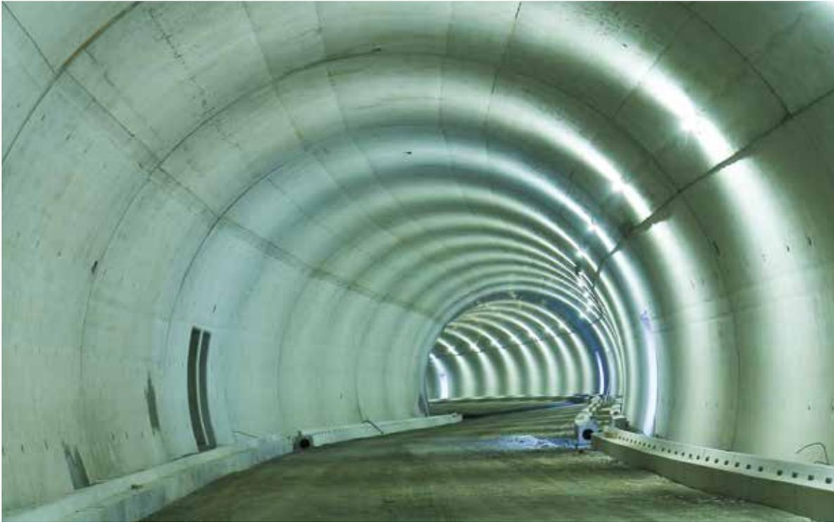
Fertiges Gewölbe mit laufendem Innenausbau (Unterbauplanum vor dem Betondeckeneinbau und der Errichtung der Bordsteine bzw. Schlitzrinne in Betonfertigteilen zur künftigen Ableitung der Fahrbahnwässer)
