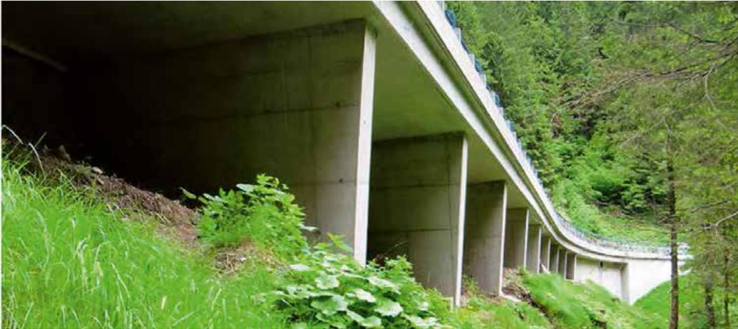
Hangbrücke mit Konstruktionstyp 1 und 2
