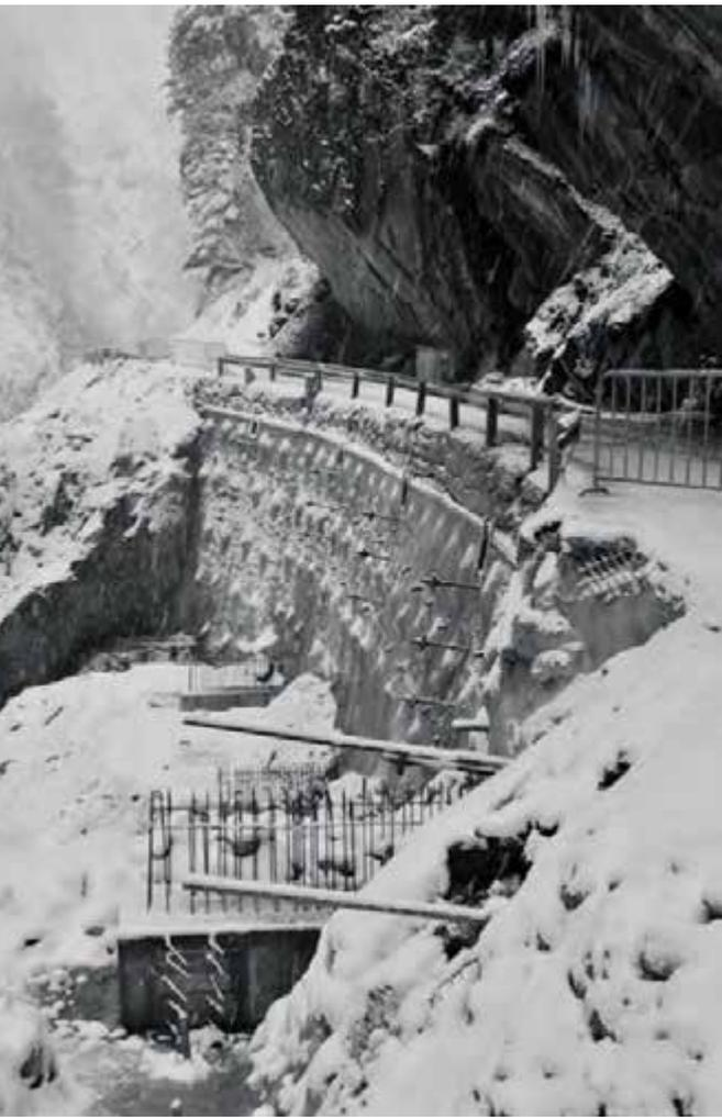
Spritzbetonsicherung mit herausragenden Ankern im Bereich der Scheiben
