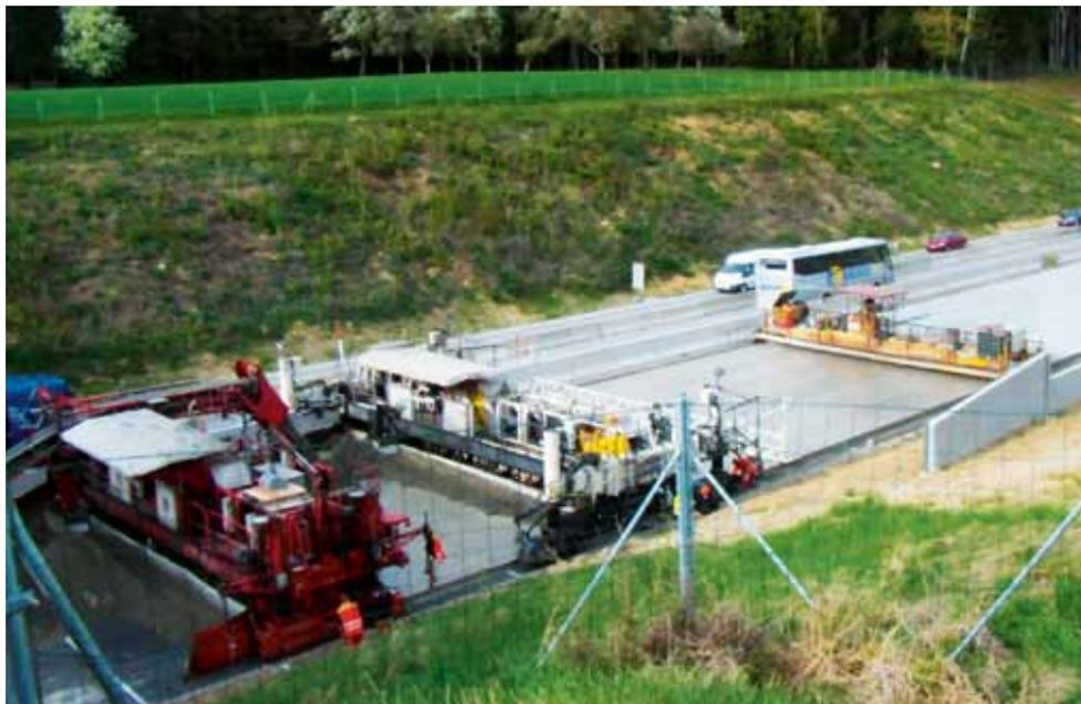
Maschinelle Betondeckenherstellung – Fertigerzug
