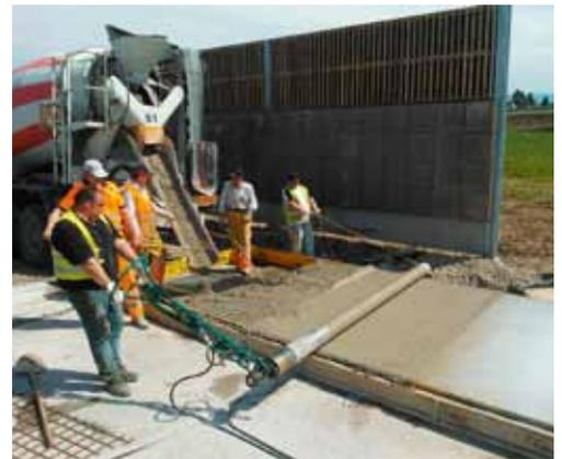
Händische Betondecke (Fließbetonfeld) – Herstellen der Oberfläche
