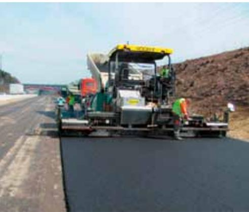
Asphalteinbau – bituminöse Tragdeckschicht
