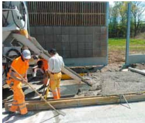
Händische Betondecke (Fließbetonfeld) – Betoneinbau
