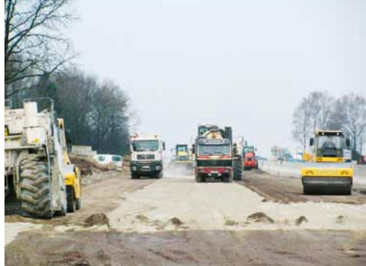
Herstellen der stabilisierten Tragschicht – Fräsvorgang/Streuvorgang des Bindemittels
