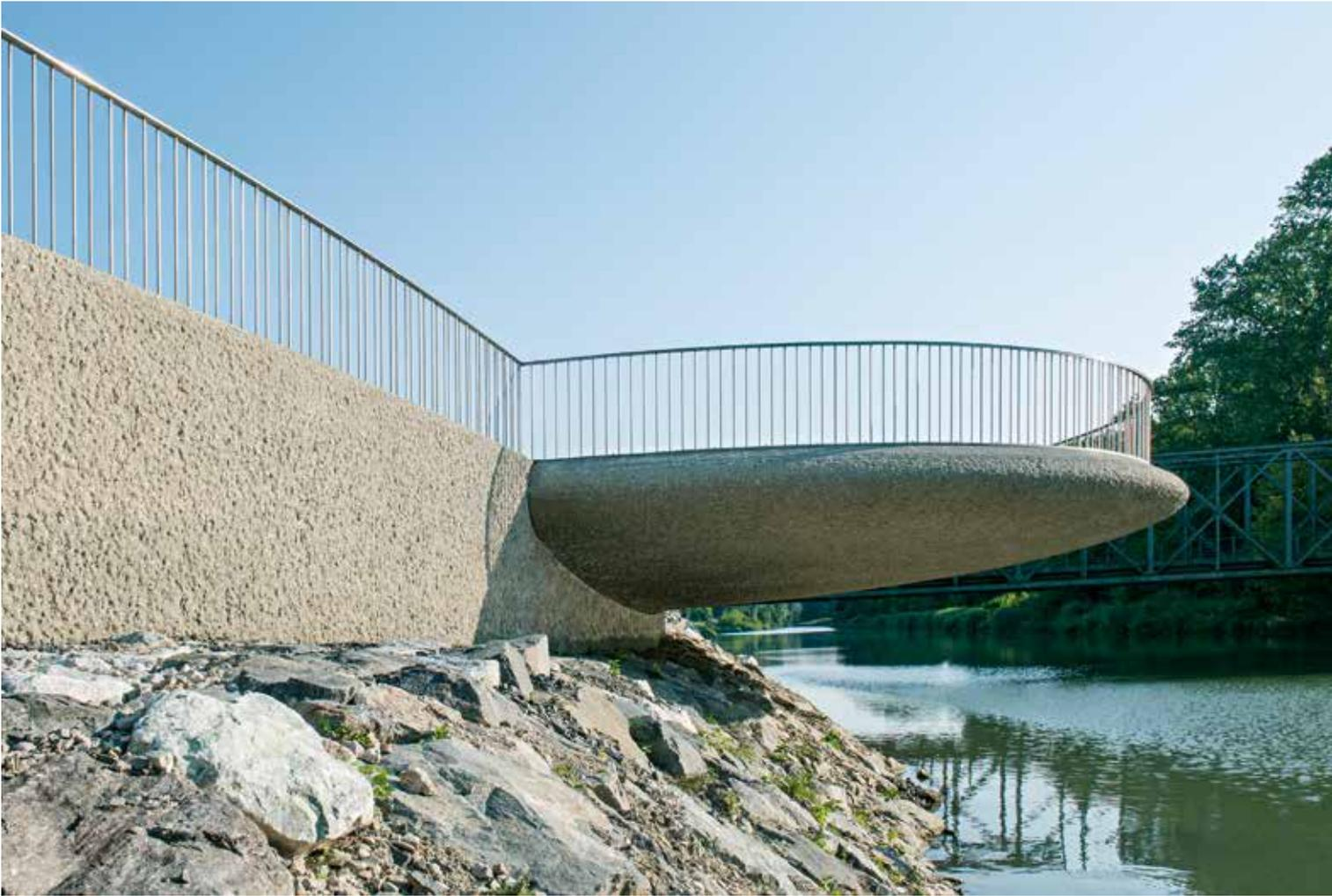
Dem Momentenverlauf und der Grundrissform folgend, handelt es sich bei dieser Kragkonstruktion um ein gequetschtes Drehellipsoid aus Stahlbeton. Die Oberfläche des speziell eingefärbten und verorteten Sichtbetons wurde in Korrespondenz zum rauen Stiftsfelsen steinmetzmäßig gespitzt.
