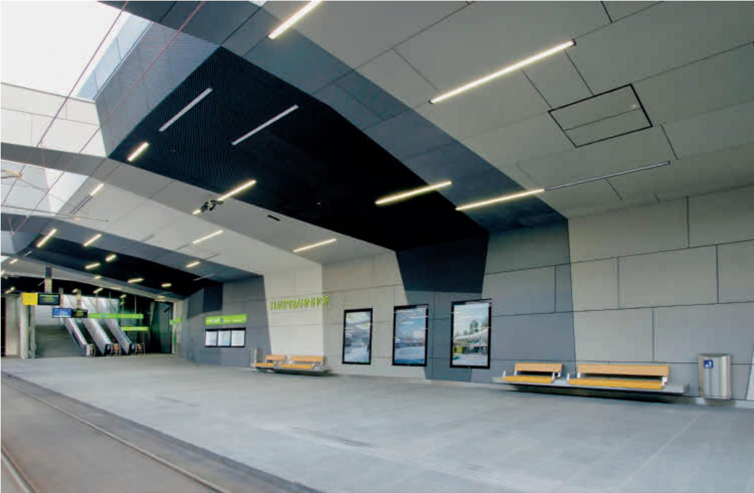
leitsystem wurde oberflächlich in die Betonplatten eingefräst. Aufmerksamkeitsfelder, Avisierungsstreifen und das „Grazer T“ wurden aus taktilen Bodenindikatoren hergestellt.
