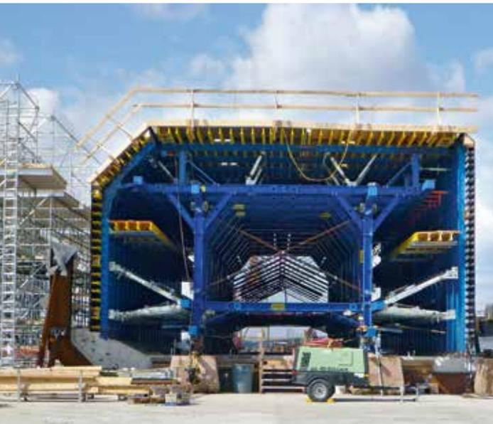
Die vorgefertigte Doka-Tunnelschalung SL-1 ist „ready to use“. Sechs Doka-Tunnelschalwagen sorgen für den planmäßigen Baufortschritt.
