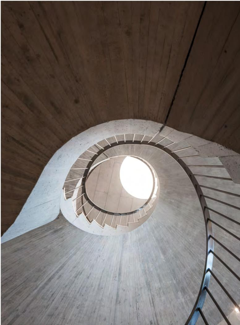
„Der Beton (mineralisch) wurde im Gegensatz zum Holz (organisch) des Fußbodens und der Fassade gewählt. Die beiden Elemente interagieren miteinander und schaffen ein Gefühl der Harmonie. Der Beton ist auch mit unbehandelten Brettern geschalt worden, was ihm das Aussehen von versteinertem Holz verleiht. Die Präsenz des Holzes ist somit im Beton zu erkennen.“
