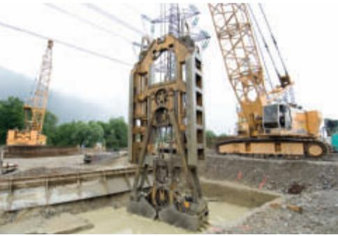
Herstellung eines Dichtblockes im Schlitzwandgreiferverfahren, im Hintergrund ist die zweite Schlitzwandeneinheit zu sehen.
