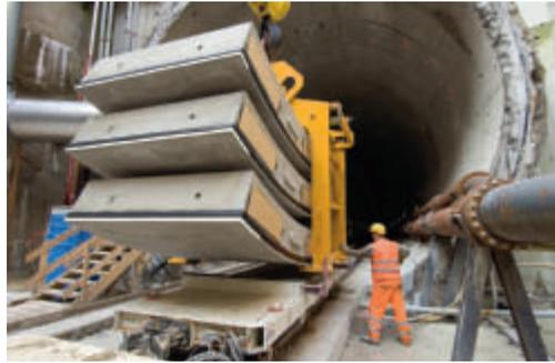
Verladen von drei Tübbingsteinen mit in Summe 45 t auf einen Flachwagen im Schacht. Rechts sind die in den Tunnel führenden Förder- und Speiseleitung zu sehen.
