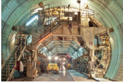
Schalwagen eines Vorläuferblockes der Brandschutzschale. Die Bewehrung am Nachläuferblock wird nach dem Wegfahren der Vorläuferschaltung geschlossen.
