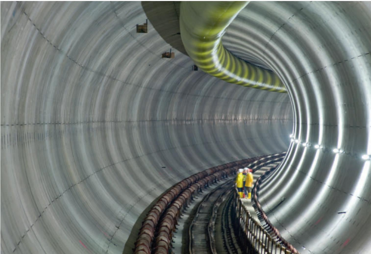
Tunnelpatin Martina Faymann und Bundeskanzler Werner Faymann besichtigen die aufgefahrene Tunnelröhre, oben ist die Lutte zur Frischluftversorgung zu sehen, in der Sohle links die Förder- und Speiseleitung, in der Mitte das Tunnelgleis und rechts der Laufsteg.
