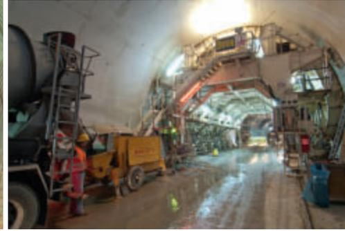
Betonage eines Nachläuferblockes der Brandschutzschale
