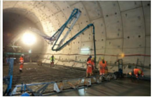
Betonage der Sohlplatte und Abzug dieser mit der Rüttelbohle
