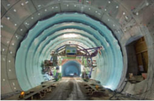
Im Hot-Melt-Verfahren mit der vollautomatischen Verlegemaschine angeklebte vlieskaschierte Abdichtungsbahnen. Rechts ist noch der Türstock eines Rettungstollens zu sehen.
