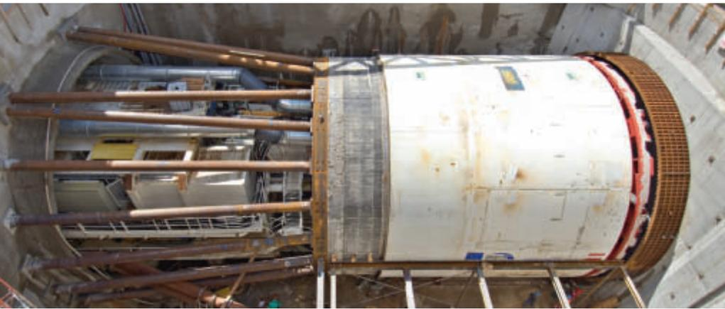
Fertig montierte TVM kurz vor dem Andrehen. Zu sehen sind die ersten Tübbingringe (grau) und die Rücksteifkonstruktion, die im Anfangsbereich die Vortriebskräfte ableitet.
