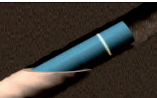
Bild 4: Druckstollen – hexagonale Tübbingauskleidung
