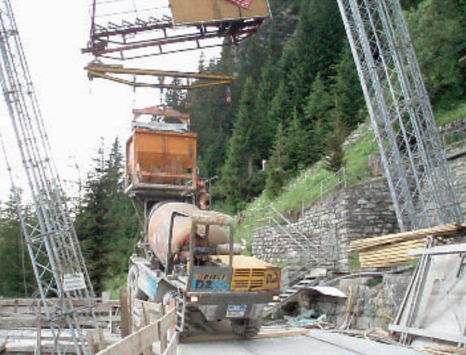
Bild 9: Betonumschlag Seilbahn Bergstation
