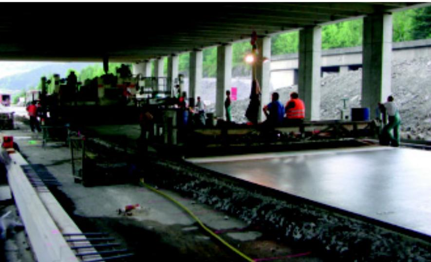
Einbau der 22 cm starken Betonfahrbahn
