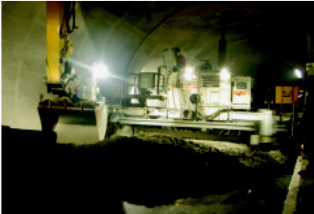
Einbau des Betons vor dem Fertiger
