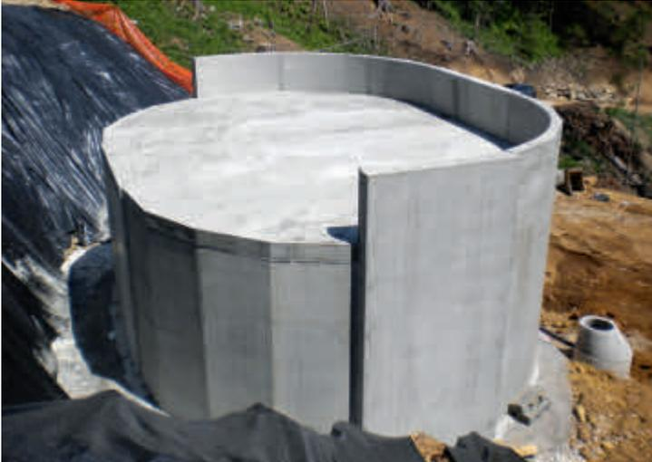
Abb. 3: Der Behälter wird hinterfüllt.
