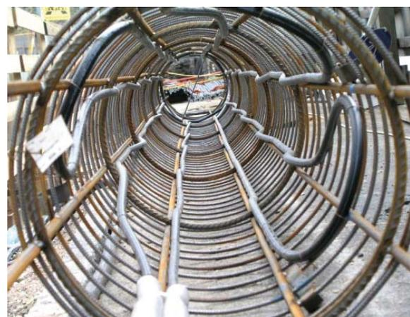
und den Fundamentpfählen (90 Stk. à 10 m tief = 900 lfm) aus der Erde bezogen. Damit können im Durchschnitt 50 Watt/lfm gewonnen werden. Die entsprechenden Berechnungen wurden von Enercret durchgeführt.
