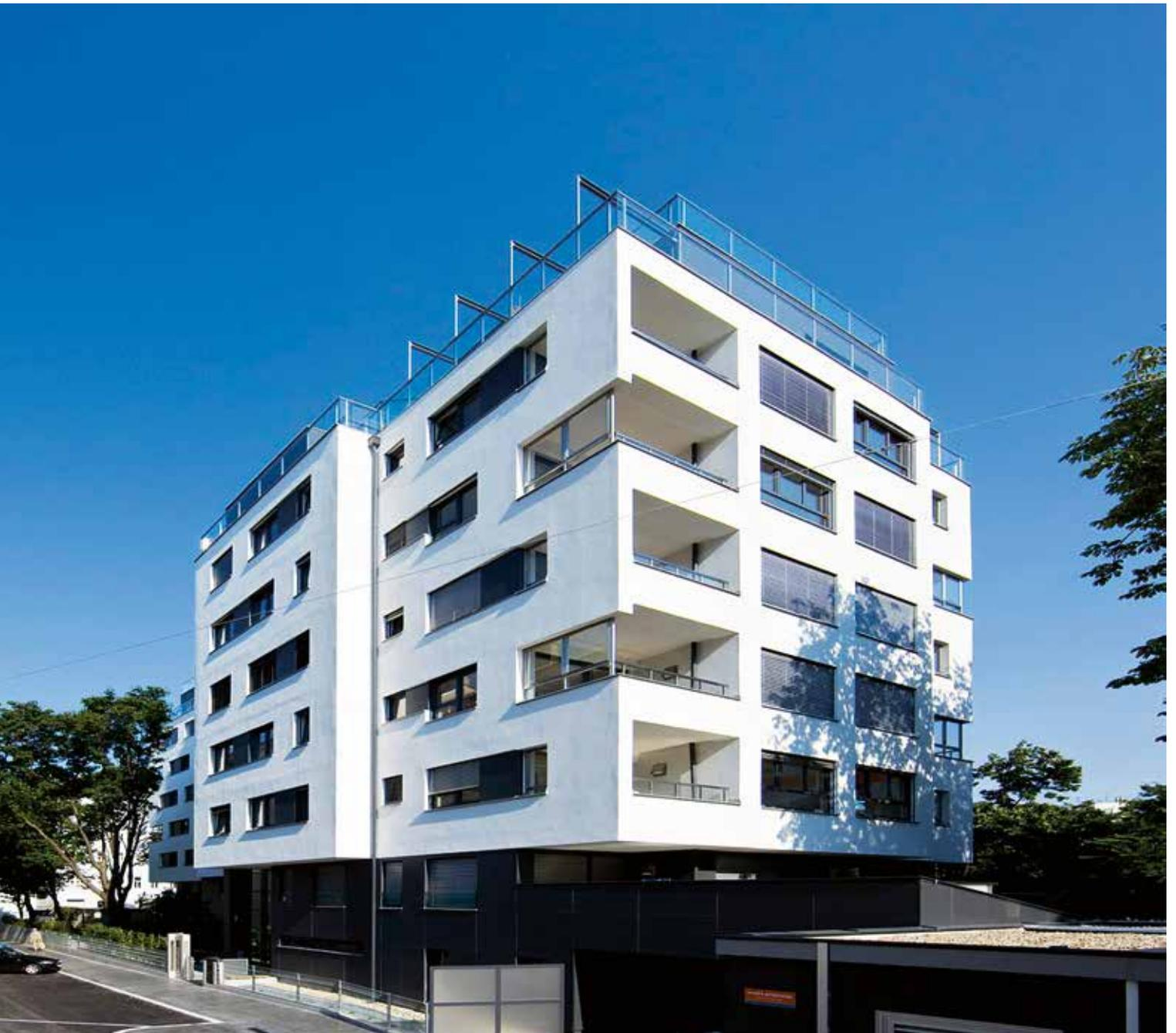
Als primärer Baustoff im Bereich der Wände und der Decken wurde das Material Beton eingesetzt. Dieses hat nicht nur einen statischen Hintergrund, sondern auch weitere Vorteile im Vergleich zu anderen Baustoffen. Die Stahlbetonwände (Massivbauweise) bieten wegen ihrer Masse einen erhöhten Schallschutz sowie einen sehr guten Massespeicher.
