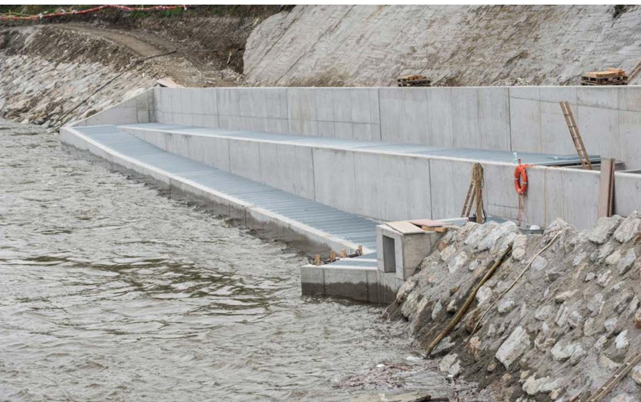
**Die Fischmigrationshilfe verfügt über eine permanente Zusatzdotations und eine zusätzliche Lockstromdotations.**
