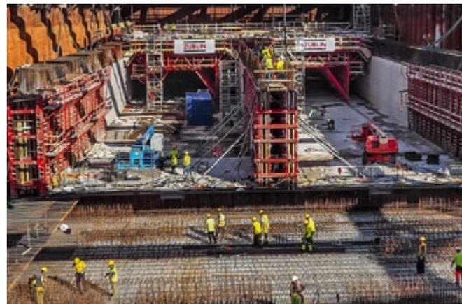
Für die doppelröhrigen Tunnelsegmente schalte und betoniert das Baustellenteam jeweils zuerst Bodenplatte und Wände in einem Guss, nachfolgend dann die Decken.
