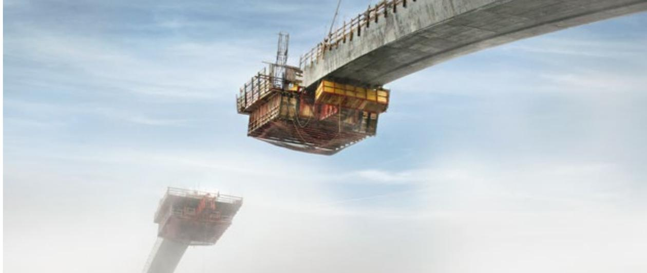
Nach dem Bogenschluss wurden die Hilfsabspannungen sowie die Hilfspylone abgebaut. Die Halte- und Rückhalte-kabel je Seilebene wurden grundsätzlich gleichzeitig entspannt, sodass, wie bei der Herstellung, die maximal zulässige horizontale Differenzkraft je Querträgererebene nicht überschritten wurde. Generell mussten an beiden Pylonen gleichzeitig die Halte- und Rückhalte-kabel je Querträgererebene, beginnend von der obersten, abgebaut werden.
