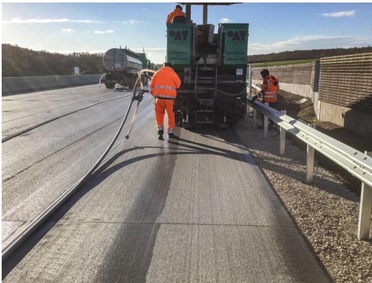
Ausführung der Grindingstruktur auf der A5
