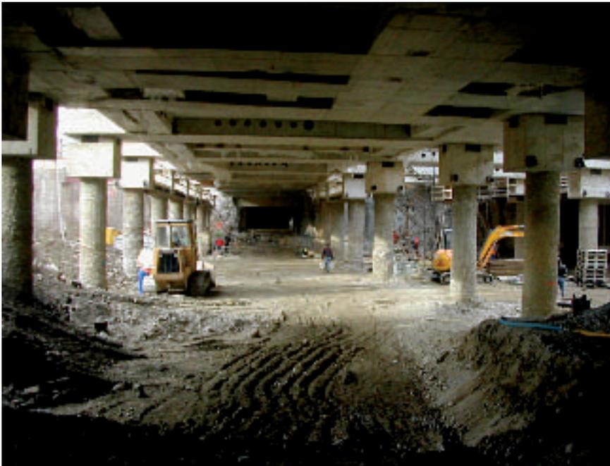
Lastumlagerung der Fundierung auf die Stahlbeton-Unterfangungskonstruktion mittels hydraulischer Pressen
