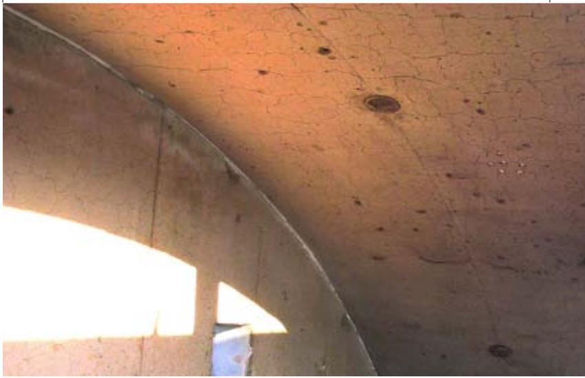
Abb. 8: Großbrandversuch Schwarzl: die Kalotte etwa 24 Stunden nach dem Brandversuch. Keine Abplatzungen am Beton erkennbar. Foto: © Wolfgang Mörth
