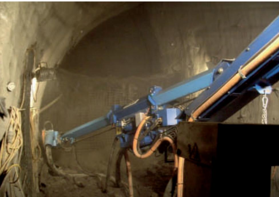
Bild 1: Ulmenvortrieb im Wienerwaldtunnel mit Nassspritzbeton
