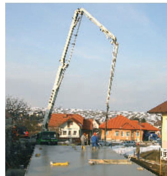
Abb 10: Fertiggestellte Kellerdecke
