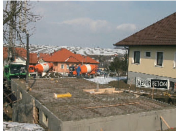
Abb 8. Kellerdecke vor dem Betonieren
