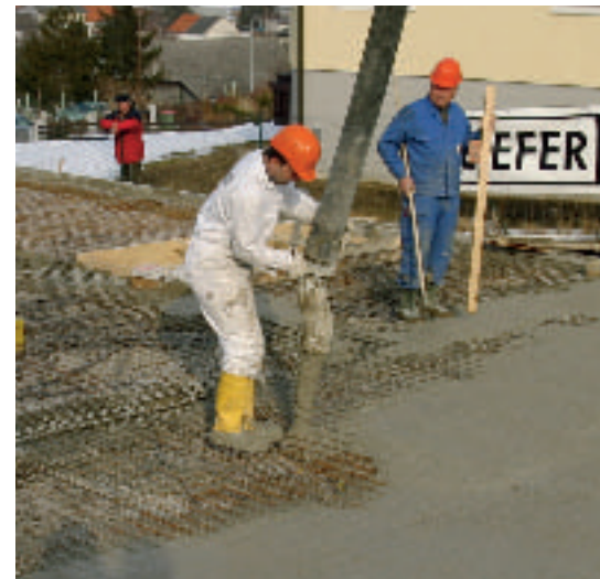
Abb 9: Einbringen des Aaton® mittels Pumpe
