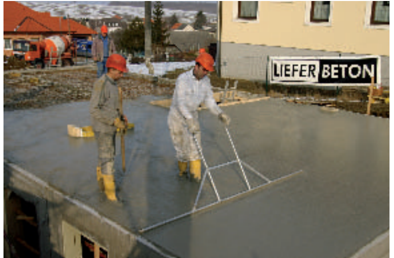
Abb. 2: Verdichten und Glätten der Oberfläche mit Schwabbelstange Foto: © Martin Billes
