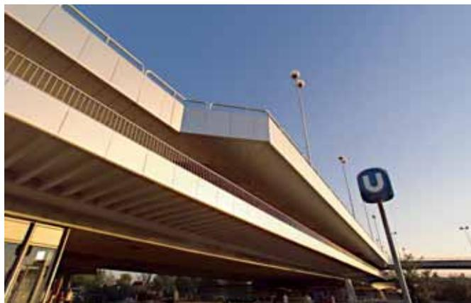
Bild 8: Verbreiteter (4,90 m) Gehweg mit Aluverbundverkleidung
