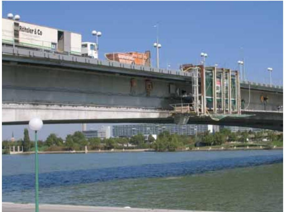
Bild 7: Abtrag der Betongehwegplatte
