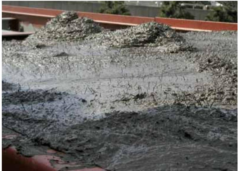
Bild 13: Hochleistungsbeton mit Fasern
