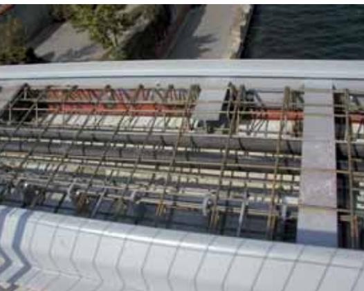
Bild 12: Schrammbord, Dübelleiste und Aussteifungen aus Stahl
