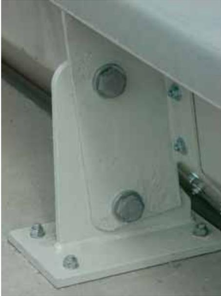
Bild 11: Befestigung Leitwand am Randstreifen
