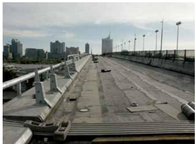
Bild 6: Fahrbahnebene neu abgedichtet, Leiteinrichtung im Aufbau
