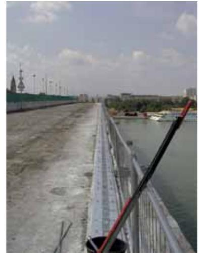
Bild 4: Freigelegte Tragwerkoberkante
