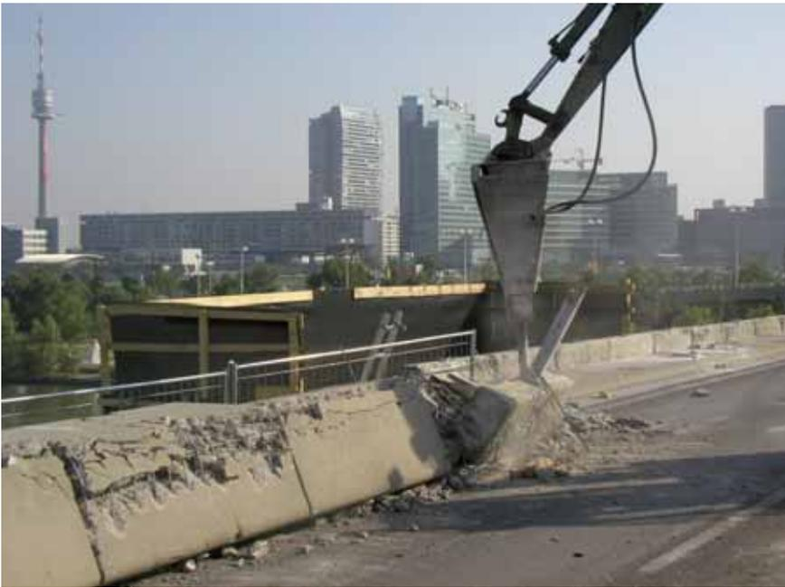
Bild 3: Abtrag der Randfertigteile aus Leichtbeton
