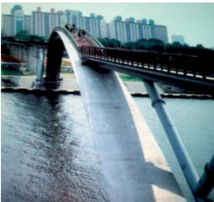
Bild 2: Der 120 m weit gespannte Bogen der Seonyu Fußgängerbrücke über den Han-Fluss in Seoul in Südkorea © LAFARGE, Ductal
