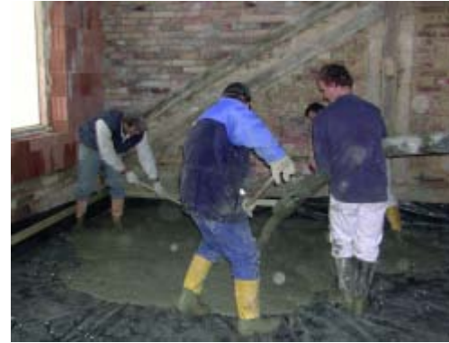
Abb. 5: Betoniervorgang auf einer bestehenden Holzdecke
