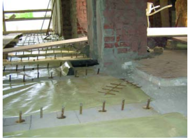
Abb. 3: Justizanstalt Wr. Neustadt, Einbau der Trennschicht
