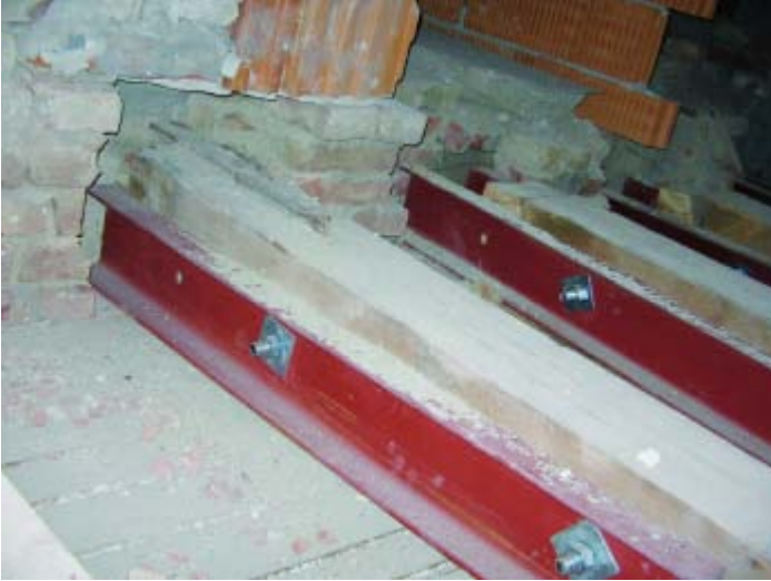
Abb. 2: Justizanstalt Wr. Neustadt, zusammengesetzte Verbunddeckensysteme: seitliche Stahllaschenverstärkung kombiniert mit verdübeltem Stahlfaserbeton-druckgurt Fotos: © E. Bölsckey
