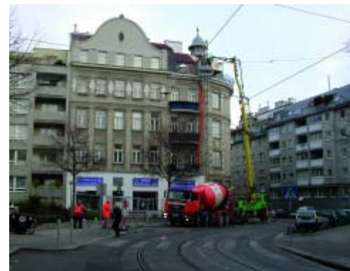
Abb. 6: Pumpen von Stahlfaserbeton in den Dachbereich eines Wohnhauses
