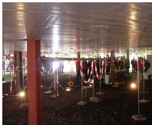
Abb. 10 Unterseite der Versuchsdecke mit elektronischen Wegaufnehmern
