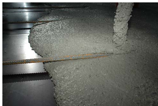
Abb. 13 + 14 Betoniervorgang eines TAB-Slab-Projektes in Tallinn/Estonia, Kolde Tee
