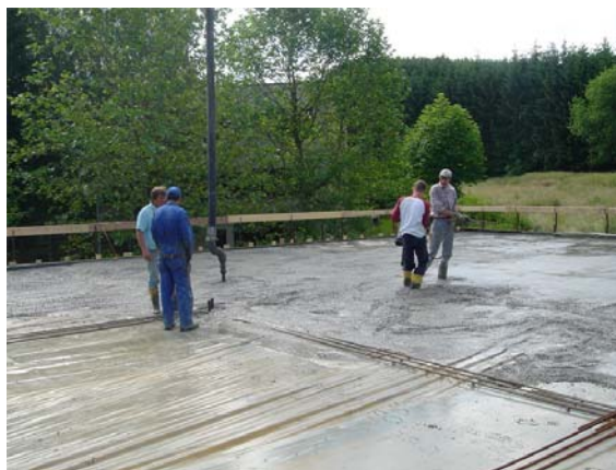
Abb. 4 Betoniervorgang der TAB-Slab®-Testdecke in Bissen – problemlose Pumpbarkeit des hochdosierten Stahlfaserbetons
