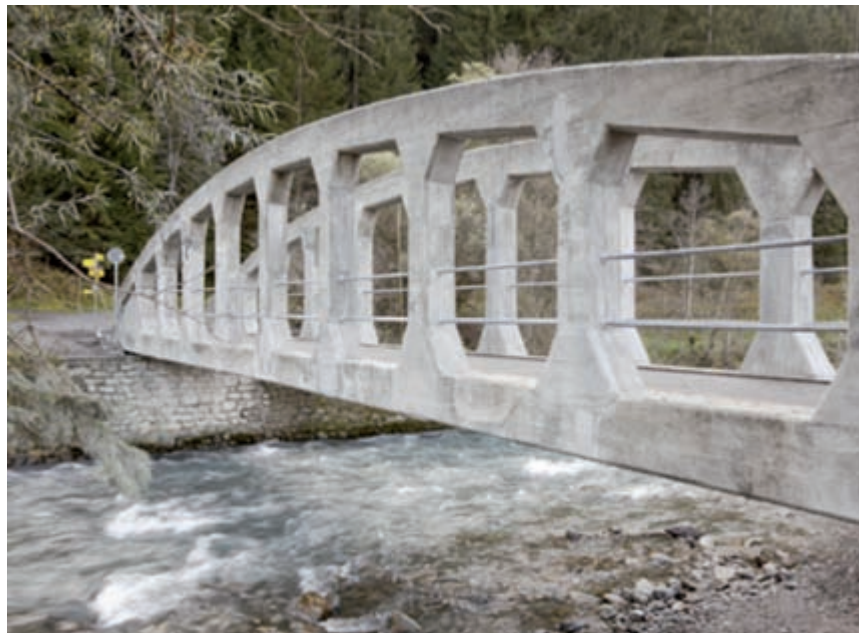
Bild 2: Die Landquartbrücke Dalvazza vor und nach der Instandsetzung
